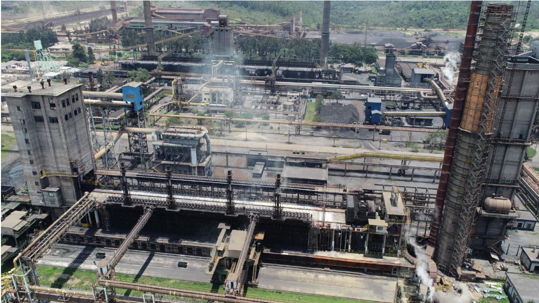
Abafamento da coqueria 2
